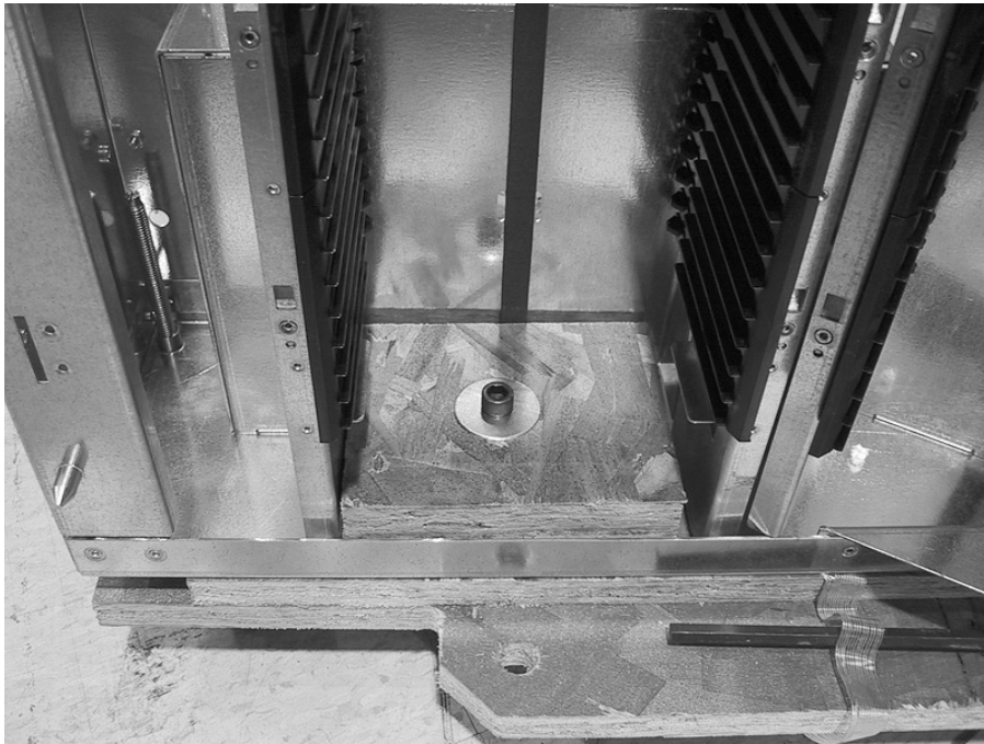
Figure 25. Expansion Bay Packing (d)
