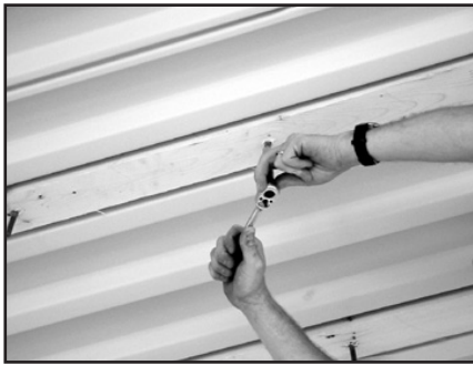
Fig. 11: Installing the hanger bolt.
