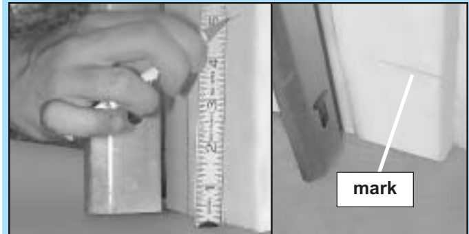
FIG. 3-1 Mark door frame.
